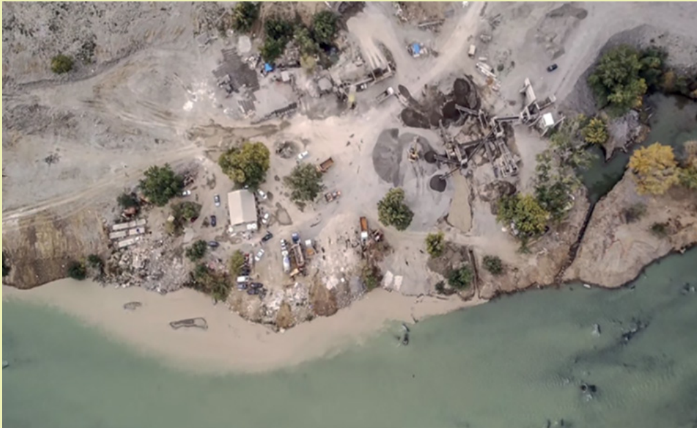
სურათი 31. შპს „ლიდერ-ბეტონის“ ტერიტორიიდან მტკვარში ჩაშვებული დაბინძურებული წყალი.
